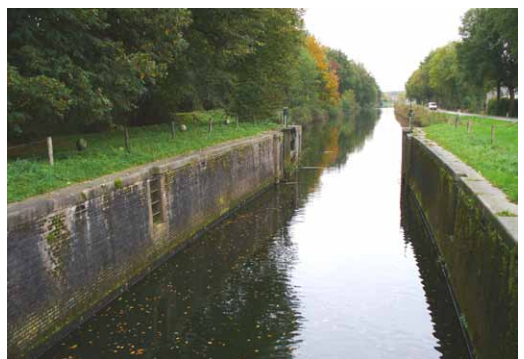
16 De Bonenburgersluis (Heerde), de laatste te renoveren historische sluis
